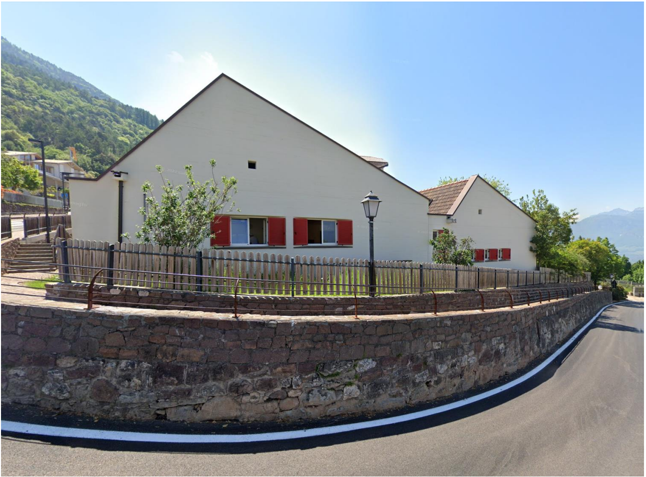
Ansicht St. Bartholomäus Straße
