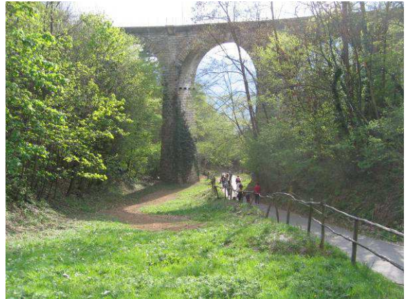
Die alte Bahntrasse ins Fleimstal steigt im Bereich von Montan über mehrere Kehren bergan. Die Strecke ist noch heute teilweise gut in der Landschaft sichtbar; besonders die alten Kunstbauten sind zum landschaftsprägenden Element geworden.
